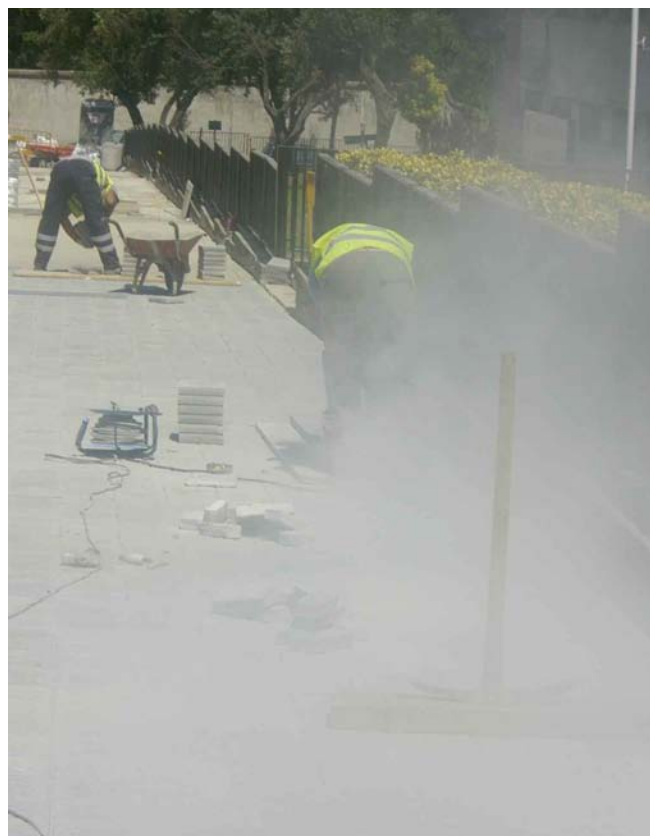
FIGURA 5. IZQUIERDA: EMISIÓN DE POLVO DE TRABAJOS CORTE DE MATERIALES DE CONSTRUCCIÓN EN SECO. DERECHA: FIRME DE RODADURA DE UNA CALLE CUBIERTO POR BARRO DEBIDO A LA PÉRDIDA DE CARGA DEL TRANSPORTE DE RESIDUOS EN UNA EXCAVACIÓN. OBRAS PÚBLICAS REALIZADAS EN LA CIUDAD DE BARCELONA.
