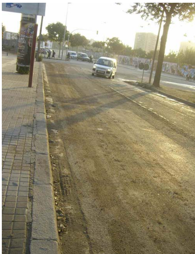
FIGURA 5. IZQUIERDA: EMISIÓN DE POLVO DE TRABAJOS CORTE DE MATERIALES DE CONSTRUCCIÓN EN SECO. DERECHA: FIRME DE RODADURA DE UNA CALLE CUBIERTO POR BARRO DEBIDO A LA PÉRDIDA DE CARGA DEL TRANSPORTE DE RESIDUOS EN UNA EXCAVACIÓN. OBRAS PÚBLICAS REALIZADAS EN LA CIUDAD DE BARCELONA.
